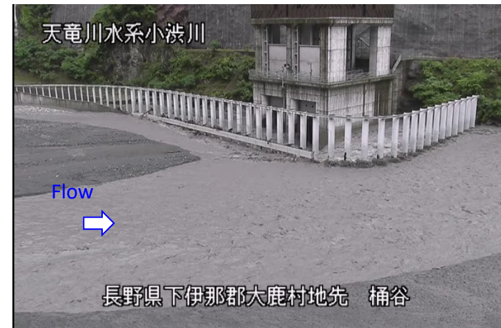
呑み口ゲート状況（7/4 11:00）ダム流入量 約170m 3 /s
