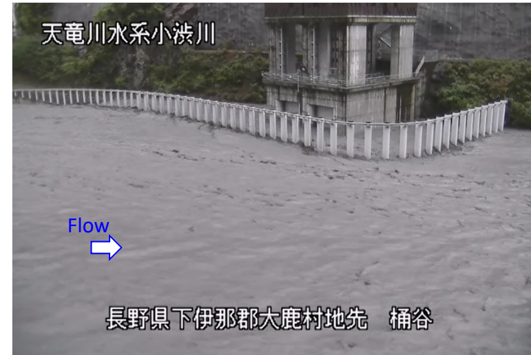
呑み口ゲート状況 (9/12 18:00)
