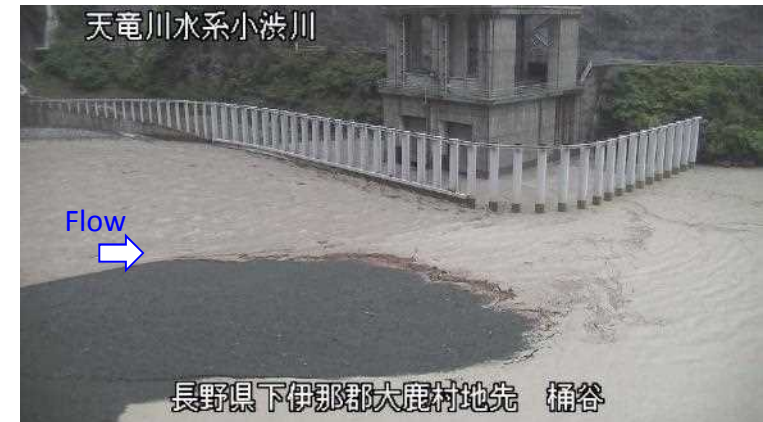
呑み口ゲート状況（7/5 6:00） ダム流入量 約180m 3 /s
