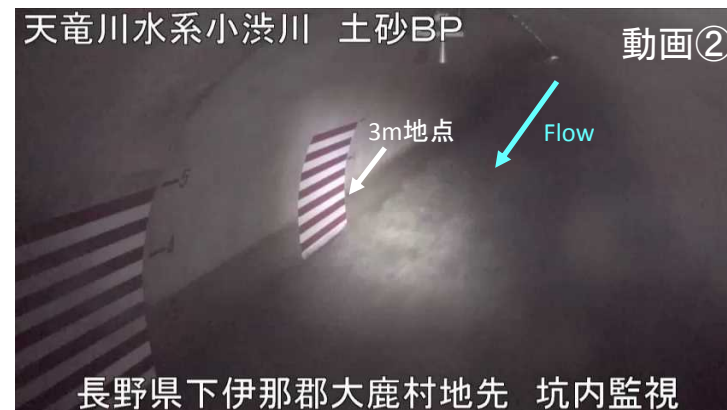
長野県下伊那郡大鹿村地先 坑内監視 流量約180m 3 /s 水深約2.0m(10/1 3:00付近) 目視計測に用いた画像(CCTVカメラ)
