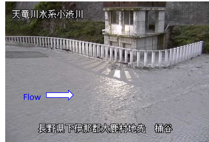
呑み口ゲート状況（10/1 4:00）ダム流入量 約280m 3 /s
