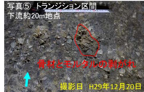
トランジション区間インバート部の凹凸状況
