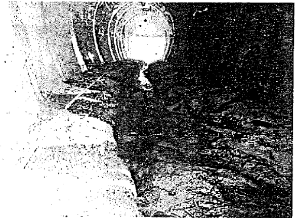
写真 小渋ダム仮排水トンネル摩耗状況 出典:「小渋ダム写真集」
