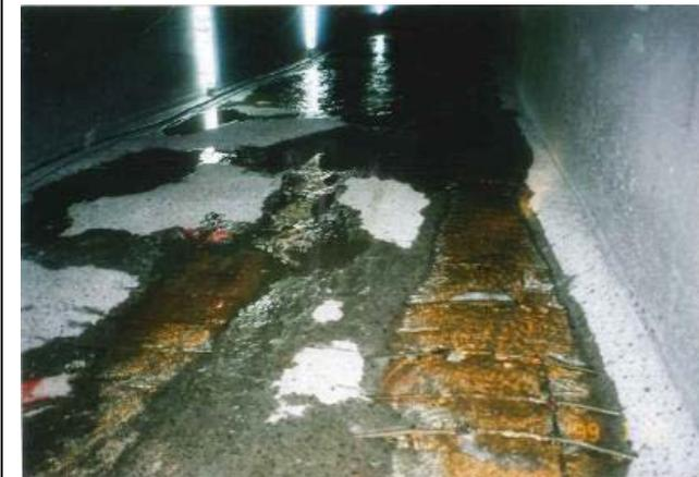
写真 旭ダムパストンネルの損耗例
