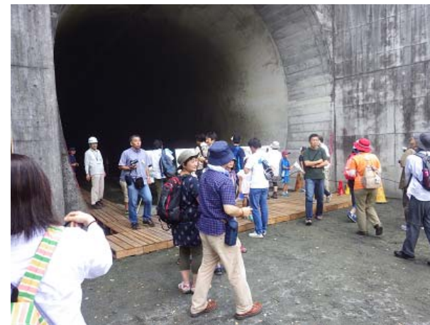
バイパストンネル吐口部
