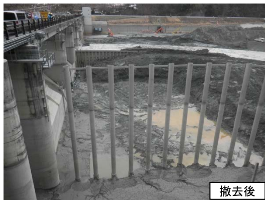
分派堰の流木(土砂含む)除去
