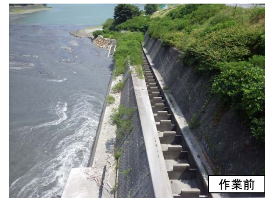
分派堰の魚道に堆積した 流木・土砂の除去および除草
