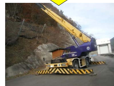
分派堰左岸の管理用通路の 防護ネットに堆積した落石の除去
