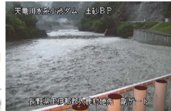
天竜川水系小渋ダム 土砂B P 長野県下伊那郡大鹿村地先 副ゲート 土砂バイパストンネル呑口上流 第3貯砂堰 (7月1日 4時20分頃)
