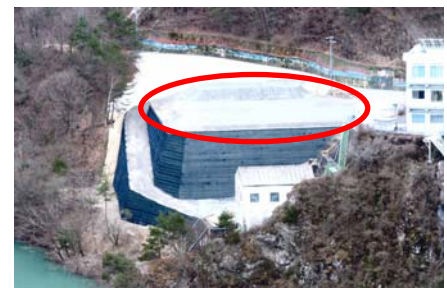
小渋ダム危機管理対策施設
