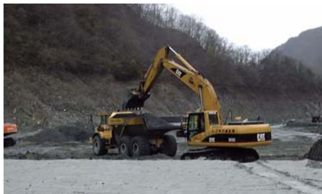
小渋ダム堆積土掘削状況
