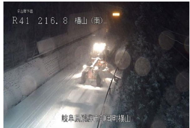
集中除雪の様子（国道41号）
