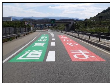
路面表示による交通誘導
