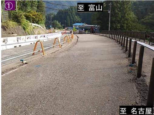
登坂車線工事を推進中
