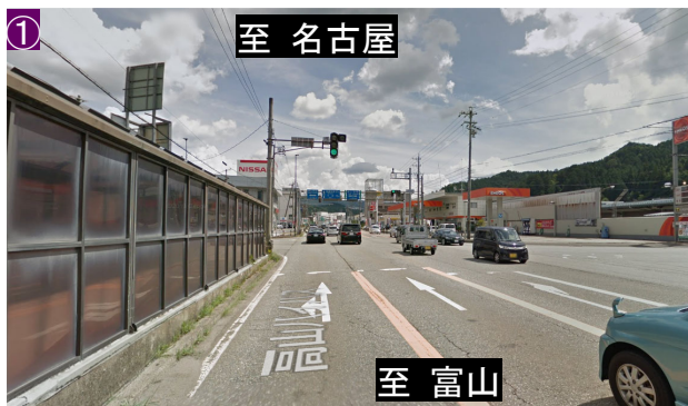
地下道上屋により視認性が悪い
