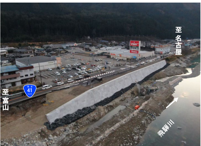
岐阜県により 護岸工事を実施
