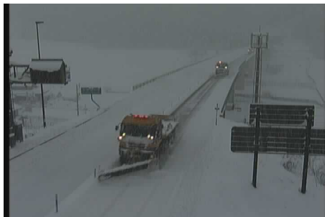
↑集中除雪の様子（中部縦貫自動車道）
