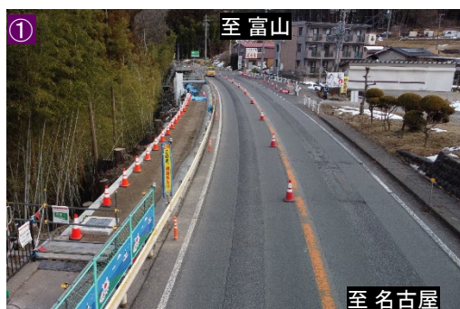
下り線側歩道整備を推進中
