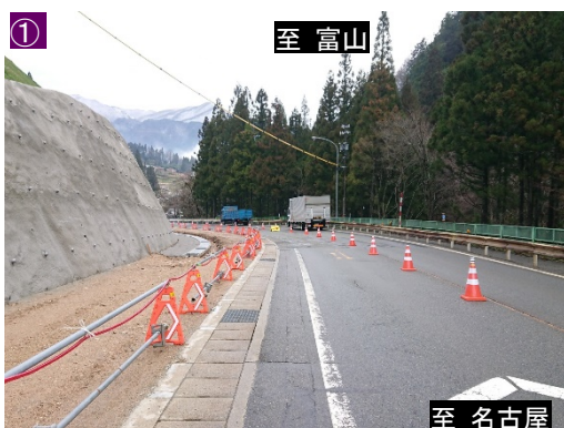
登坂車線工事を推進中
