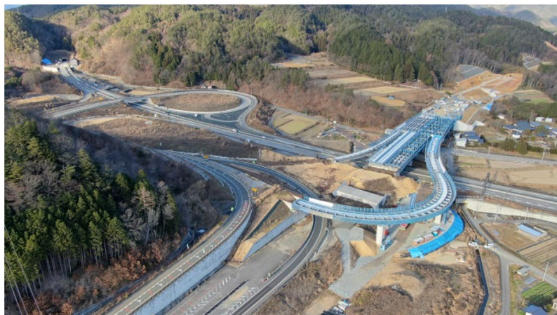
国道158号高山清見道路 高山ICから丹生川IC(仮称)方面を望む（令和2年1月12日撮影）
