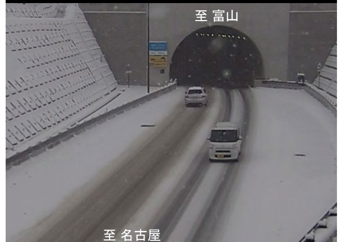
写真②: 宮峠トンネル(久々野町側) 【急勾配・急カーブのないトンネル構造】
