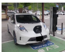
EV充電施設
