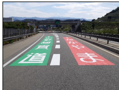
路面標示による交通誘導
