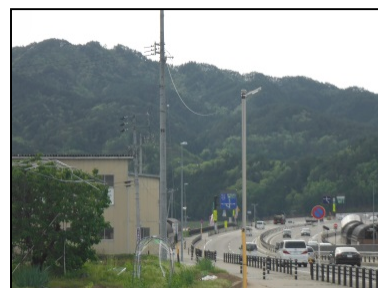
現在の建柱状況
