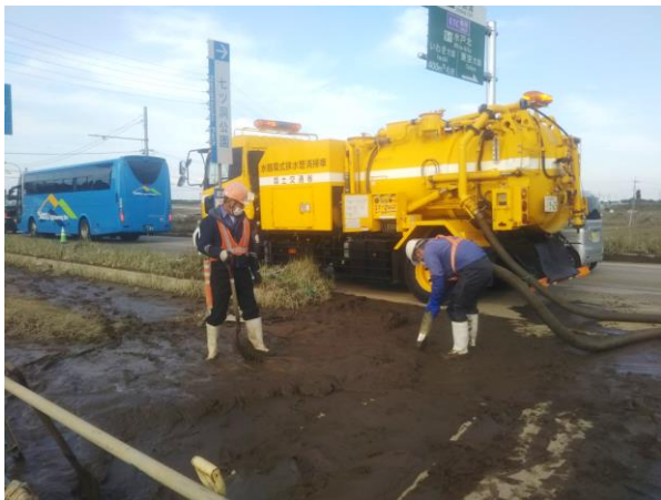
側溝の清掃（茨城県水戸市）
