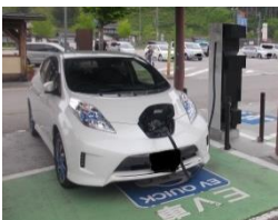
EV充電施設
