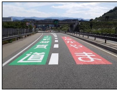
路面標示による交通誘導
