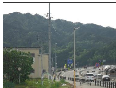
現在の建柱状況
