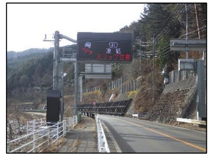
標示板による道路情報提供
