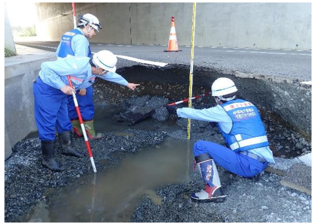
道路の被害状況調査 （福島県南相馬市）
