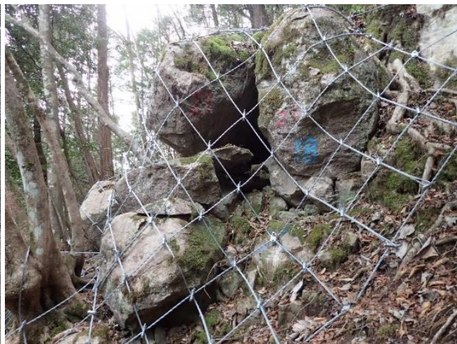
発生源対策工法の例
