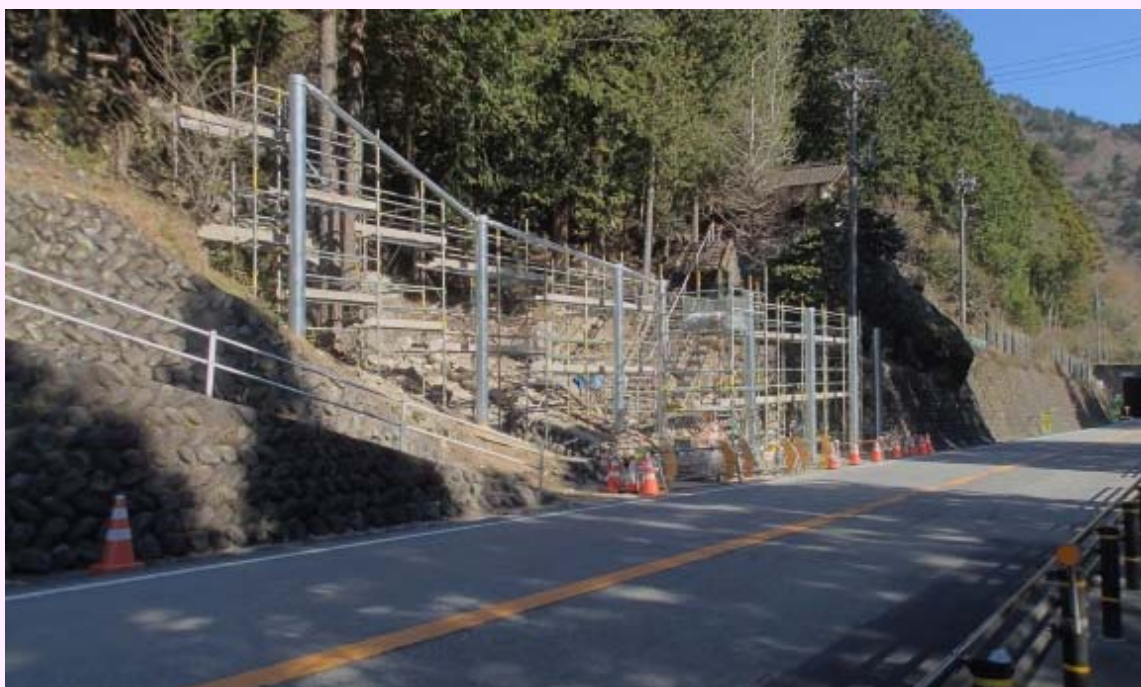
H31.4 復旧工事施工中
