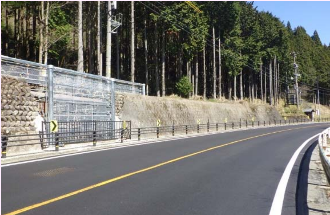
H31.4 復旧工事完成
