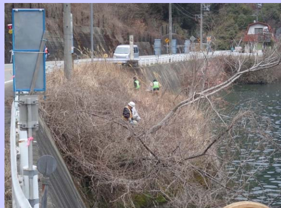
川岸の清掃作業
