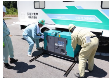
〈発電機を固定する様子〉
