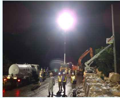
被災現場での夜間復旧作業を支援する照明車
