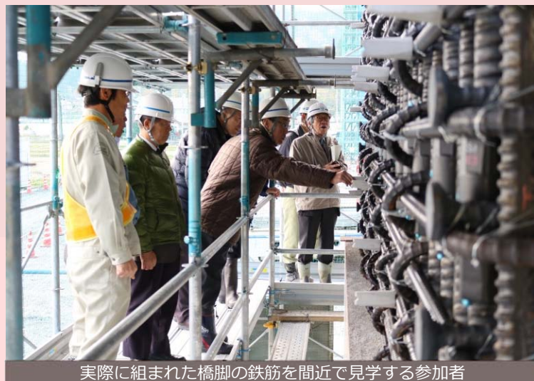
D51mmの鉄筋同士を繋ぐ“繋ぎ手”を実演
