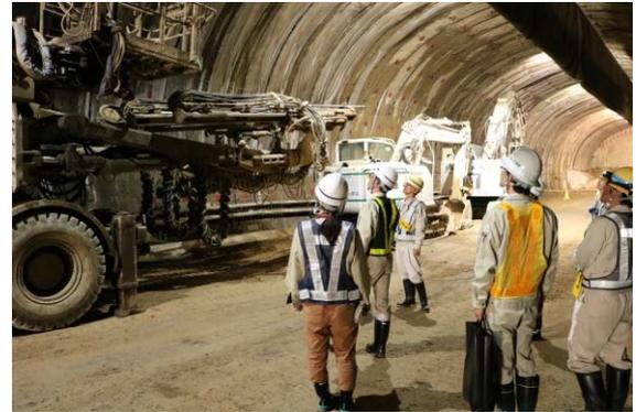
掘削中の上野第2トンネル(仮称)で本坑の作業機械(ドリルジャンボ)について説明
