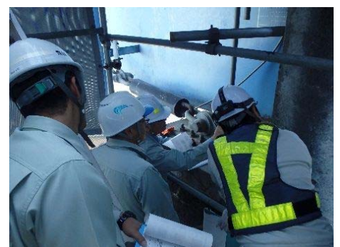
補修工事現場見学
