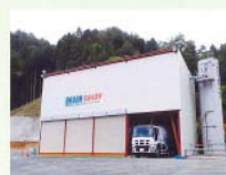
吹付コンクリートプラント
