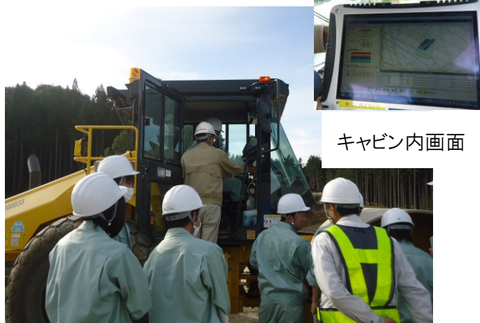
振動ローラーによるデモンストレーション
