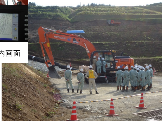
ICT油圧ショベルのデモンストレーション
