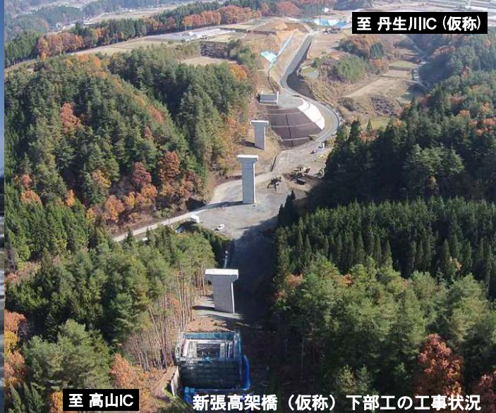
高山IC付近の下部工の工事状況
