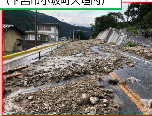
山腹崩落による土砂流入 (下呂市萩原町奥田洞)
