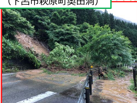
山腹崩落による土砂流入 (下呂市萩原町奥田洞)
