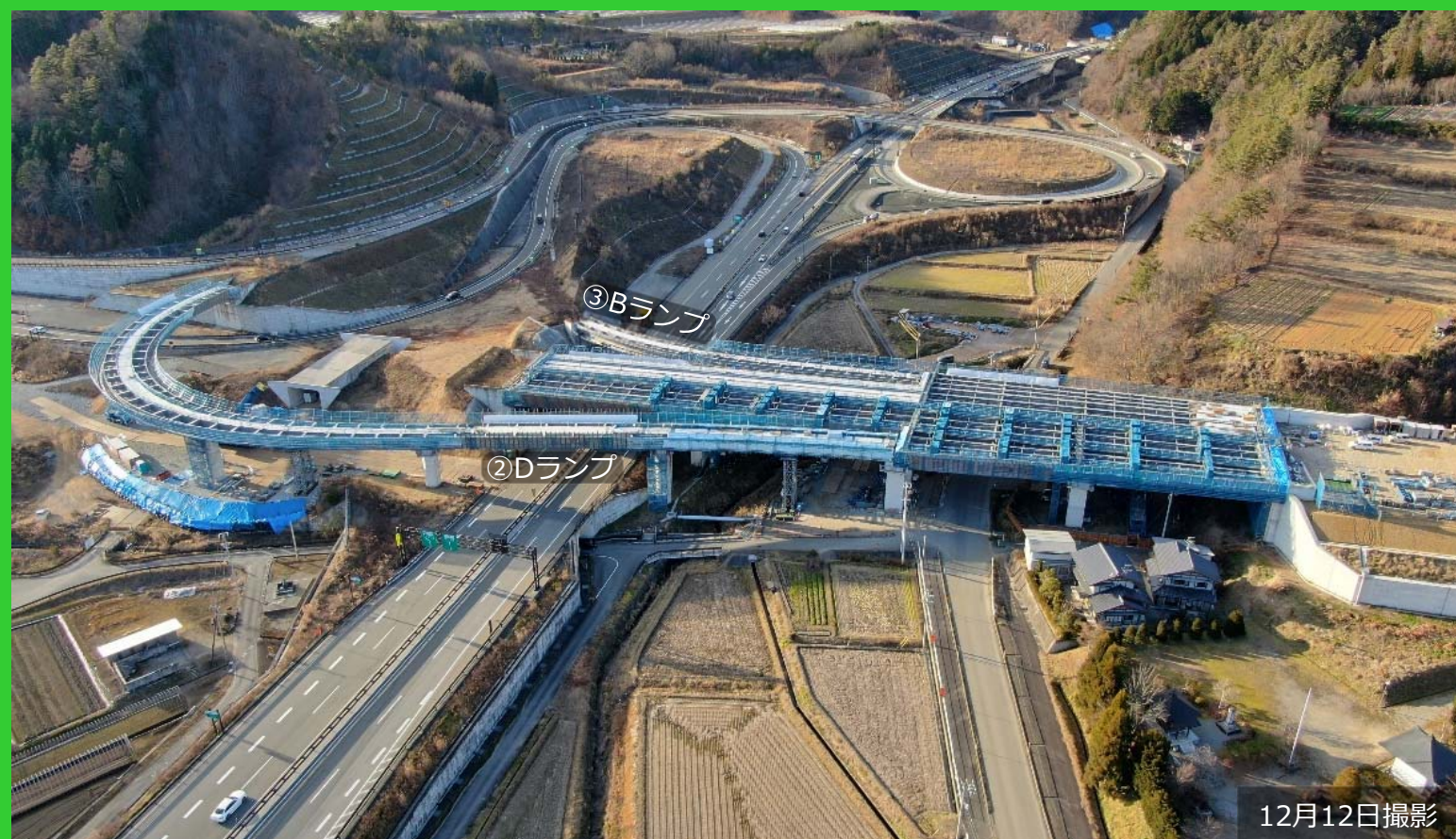
①架け終えた高山IC橋 (コンクリート床板はこれからです)
