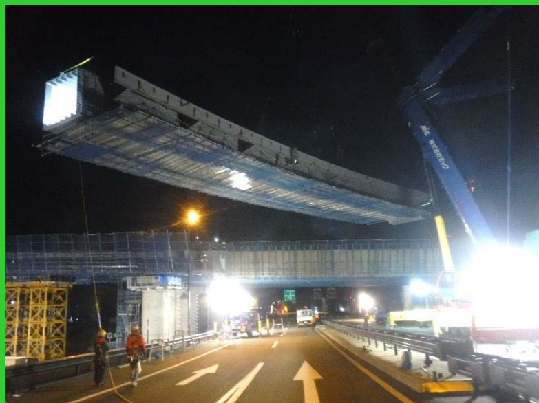
③41号上空のBランプ橋 (夜間架設)
