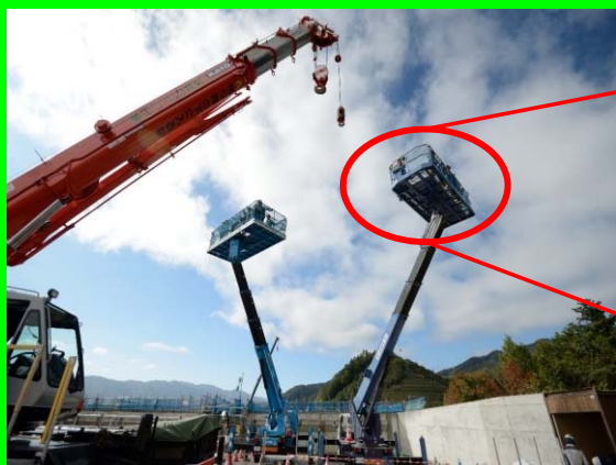
高所作業車に乗車
