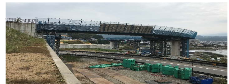
⑧中部縦貫上のDランプ橋
