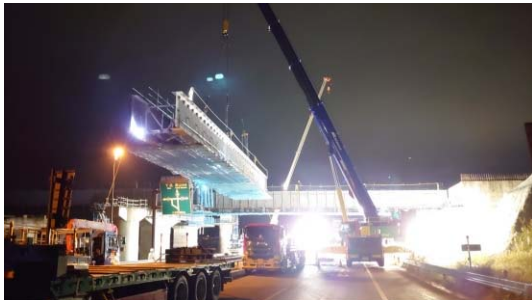
③多軸台車から200tクレーンで桁を吊り上げる
