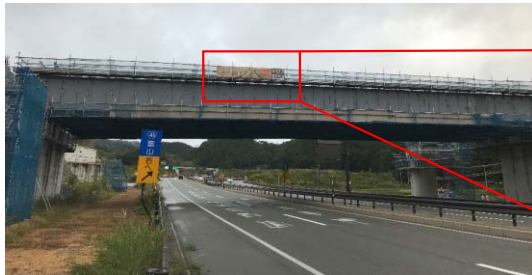
⑤41号上空の本線橋(上り線)
