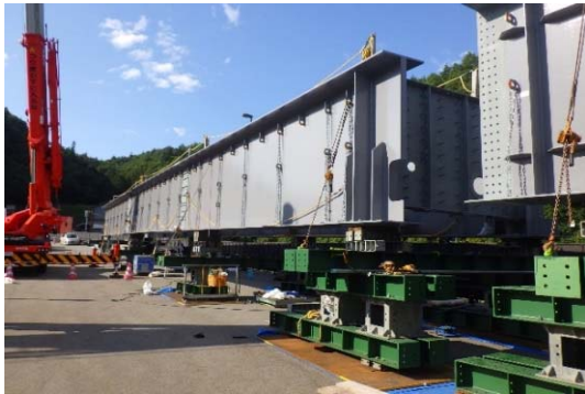
①チェーンベースで地組(架設するサイズに組立)
