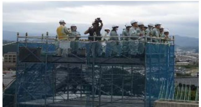
②見学ステージから架設現場を見学
