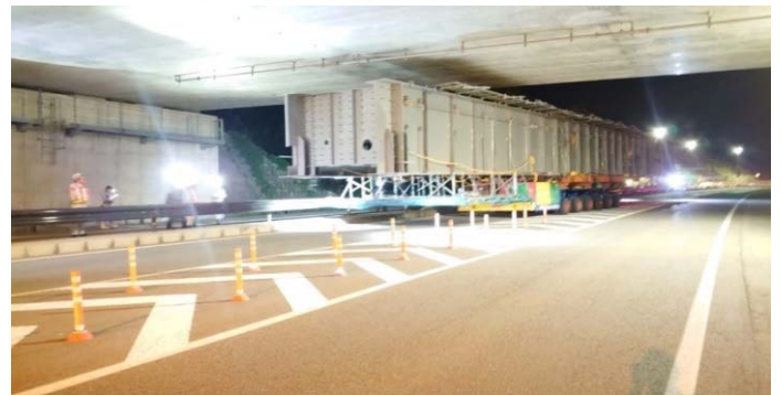
②多軸台車で、架設位置まで移動
