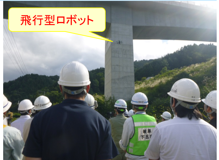
飛行型ロボットによる点検状況
