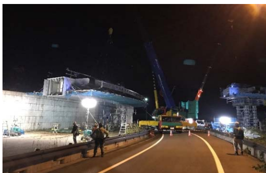
⑦中部縦貫上のDランプ橋も夜間架設
