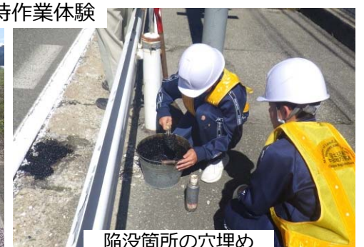
陥没箇所の穴埋め
