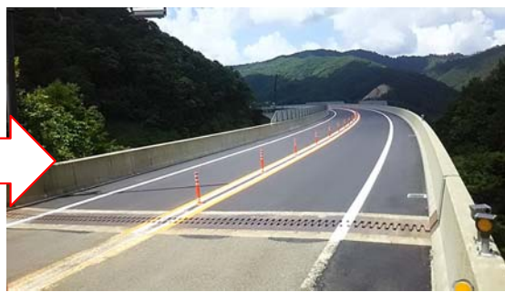
舗装を復旧して完成
