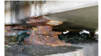
漏水による腐食(支承)
