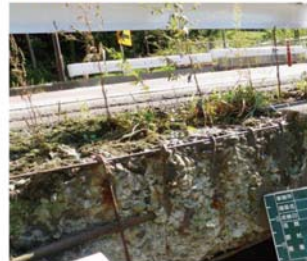
凍害によるコンクリートの剥離
