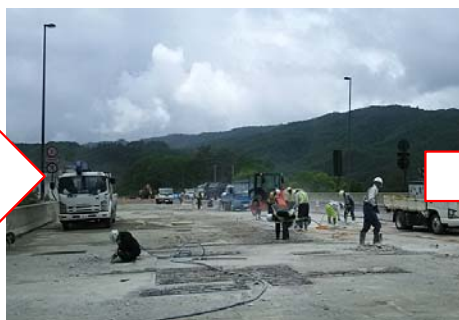
傷んだ部分を補修
