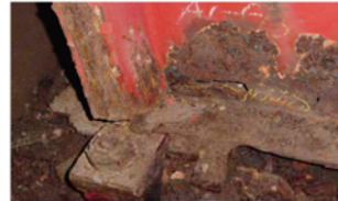
漏水による腐食(桁端部)
