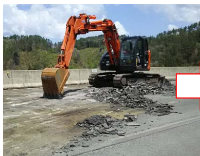
舗装を全部はがす
