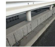
\*中性化: コンクリート中の水酸化カルシウムが二酸化炭素の吸収によって減少する事で、中性化によるコンクリートの劣化を促進し、鉄筋の腐食を引き起こす原因となる。
