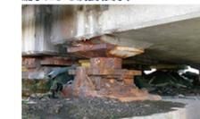
凍害によるコンクリートの剥離
