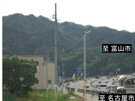
現在の建柱状況
