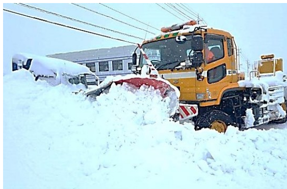
除雪トラックによる除雪作業
