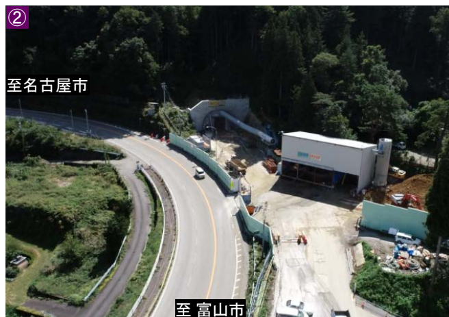
宮峠トンネル坑口部周辺の状況
