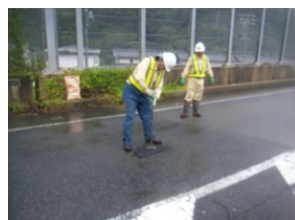
道路に空いた穴を埋める様子
