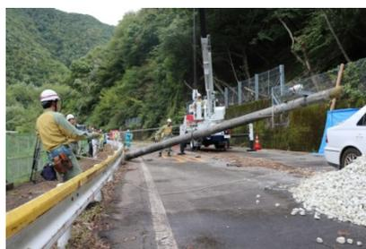
倒壊した電柱の撤去
