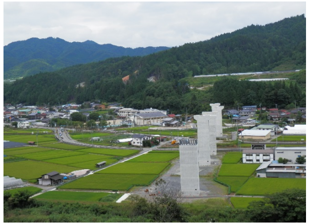
坑口から望む下切高架橋工事
