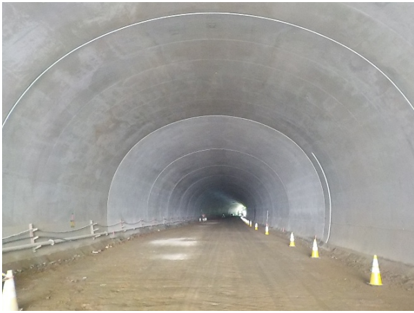
上野トンネル(仮称)
