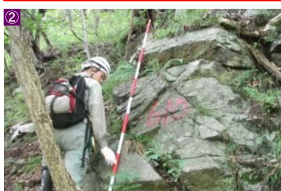
転石・浮石等危険箇所の状況
