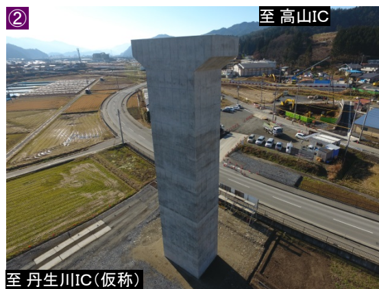
下切高架橋（仮称）下部工の工事状況
