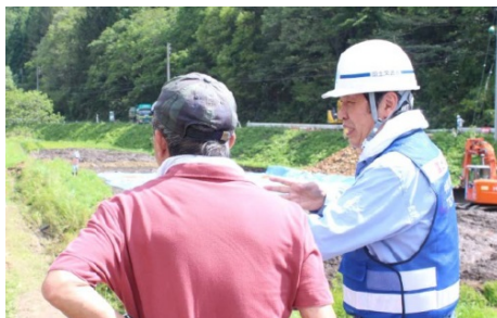
住民の方へ工事状況説明
