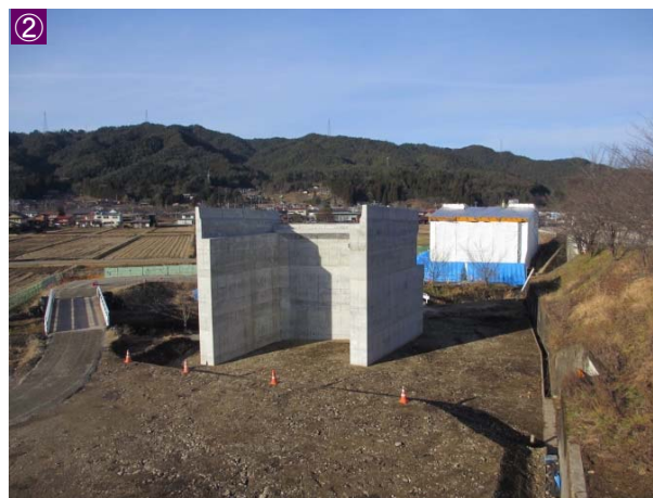
常泉寺川橋下部工工事の状況
