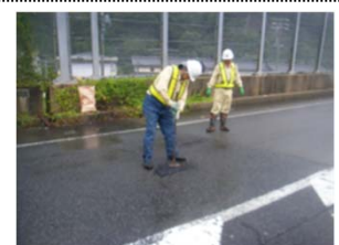
道路に空いた穴を埋める様子
