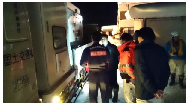
安定した上水道の確保のため 浄水場に電源供給車が到着
