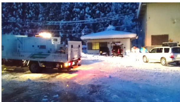
停電地域の浄水場へ電源供給車を派遣
