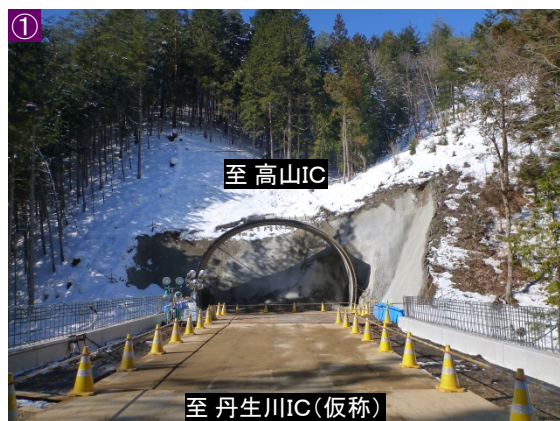
上野第2トンネル坑口の工事状況
