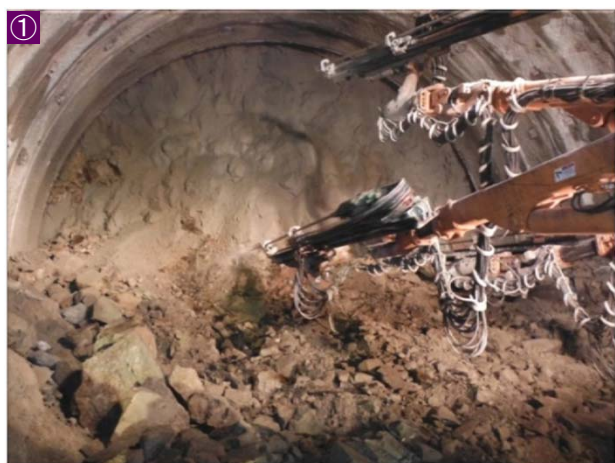
宮峠トンネル工事の状況
