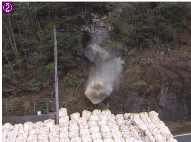
平成25年12月11日に実施した 落石除去の状況
