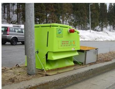
定置式凍結防止剤散布装置
