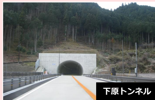
国道41号 下原改良 [平成27年11月開通]
