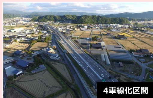
国道41号 高山国府バイパス [平成27年10月事業完了]
