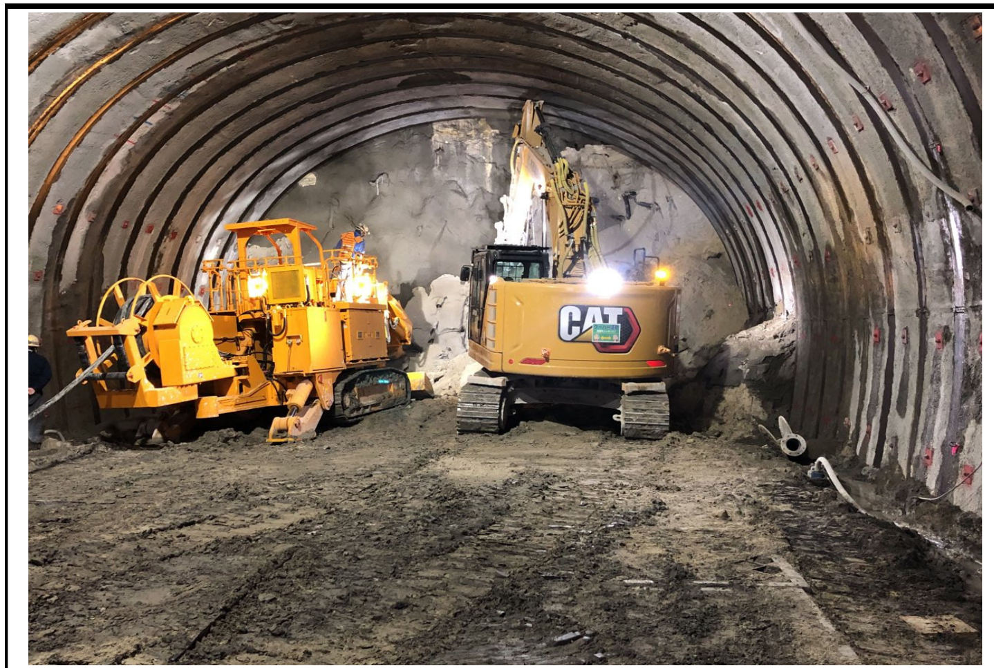
図 1. 見学場所（トンネル坑内）
