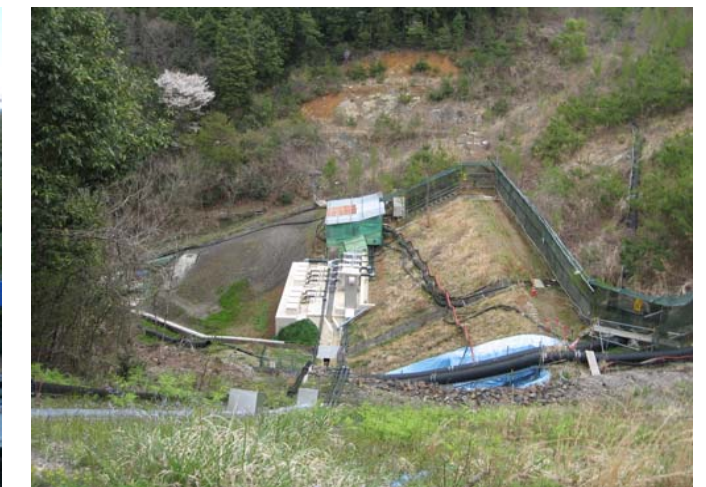
中継槽・受槽
