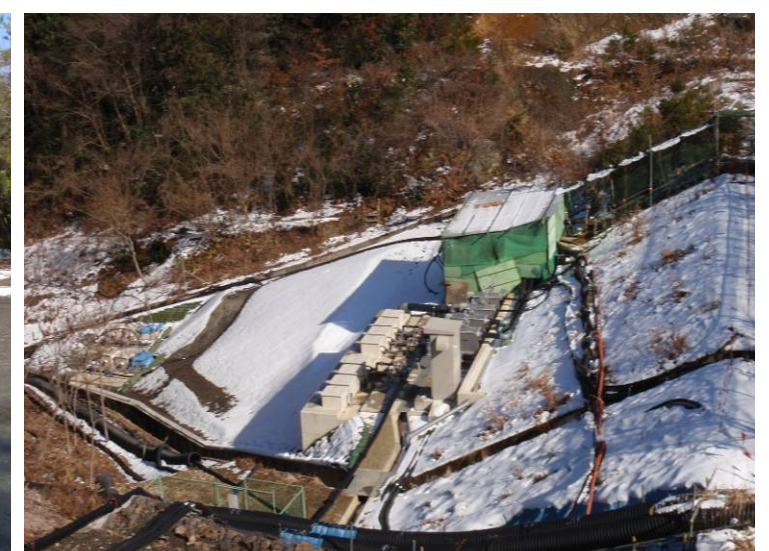
中継槽・受槽
