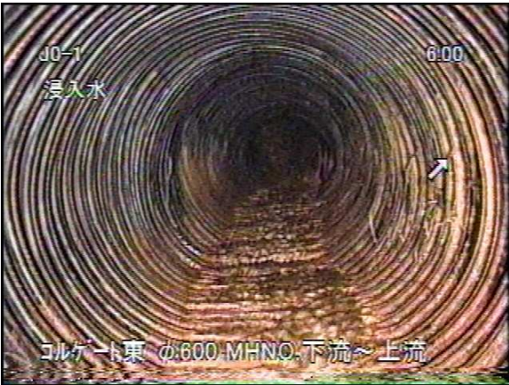
写真-1 出口から 6.5m 付近 (勾配があるため水深は浅い)
