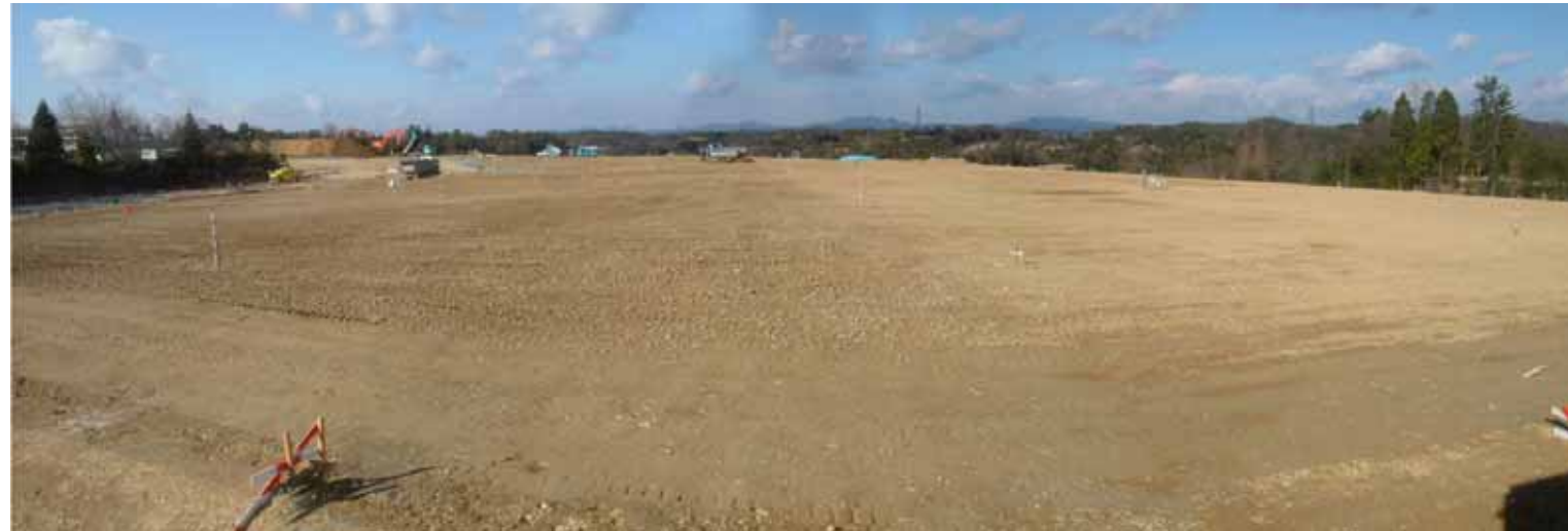
図 1.1.1 東ブロックの施工状況（1月21日時点）
