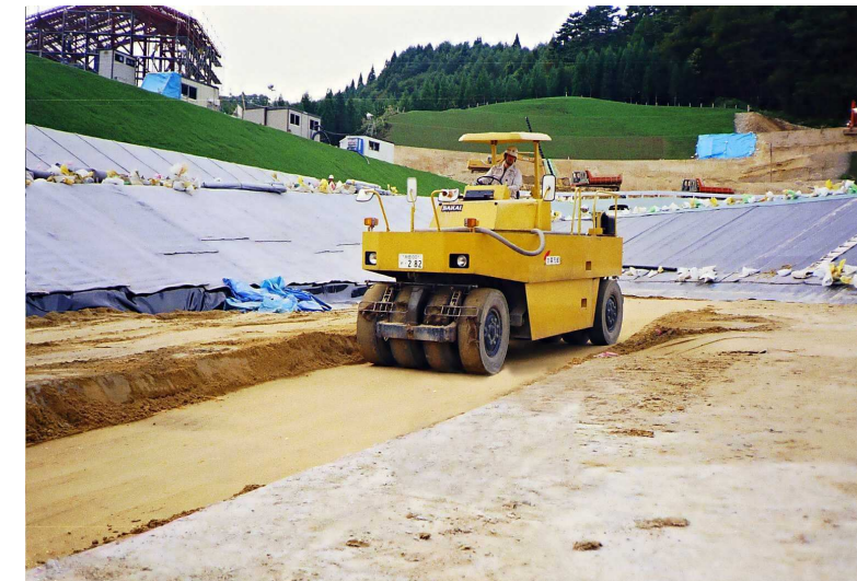
ベントナイト混合土転圧状況
