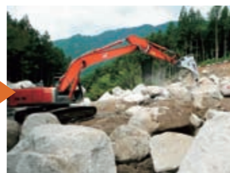
堆積した土砂等の撤去(除石)状況
