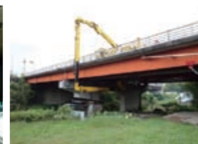
橋梁点検車による点検
