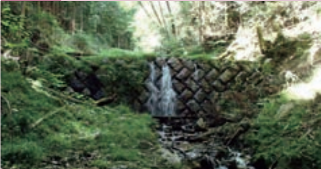
昭和23年度完成 堤高：5m 堤長：26m 形式：空石積堰堤 登録基準：再現することが容易ではないもの
