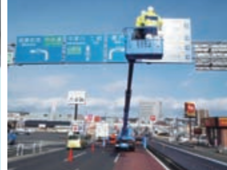
道路標識の点検 19号多治見市音羽町地内
