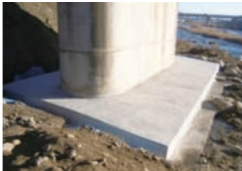
橋梁の橋脚修繕（19号土岐市泉池ノ上町地内（土岐大橋））
