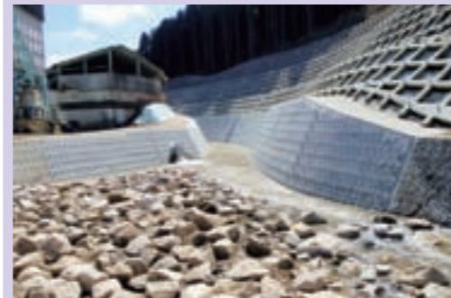
かさほらがわ 笠原川床固工群(多治見市、土岐市)
