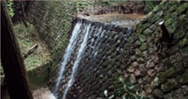
昭和18年度完成 堤高：5m 堤長：28m 形式：空石積堰堤 登録基準：再現することが容易ではないもの
