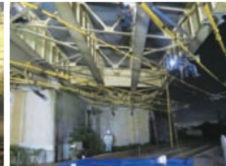
特殊高所技術による点検 19号瑞浪市土岐町地内（鶴城跨線橋）
