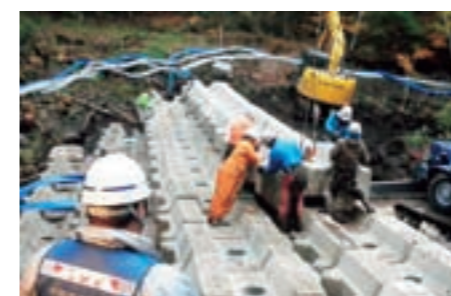
ブロック積み砂防堰堤設置の状況
