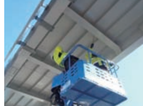
横断歩道橋の点検 19号多治見市池田町地内（池田横断歩道橋）
