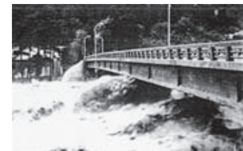
南木曽橋の主桁にせまる濁流（出典：「中部の水害」）
