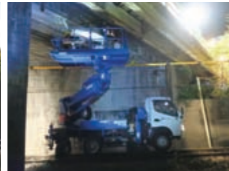
軌陸車による点検 19号土岐市泉町地内（日の出第1跨線橋）
