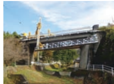
橋梁点検車による点検 19号中津川市山口地内（大又沢橋）
