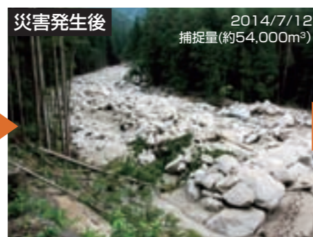
災害後の土砂等の捕捉状況
