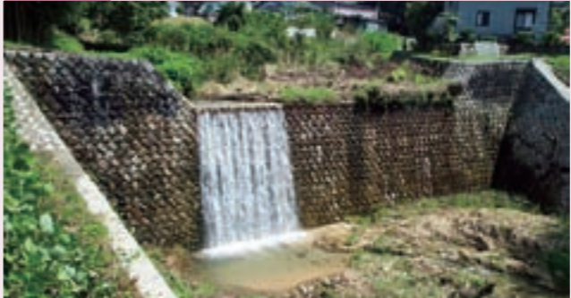
昭和14年度完成 堤高：8m 堤長：42m 形式：練石積堰堤 登録基準：国土の歴史的景観に寄与しているもの
