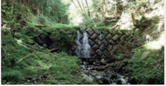
昭和23年度完成 堤高：5m 堤長：26m 形式：空石積堰堤
