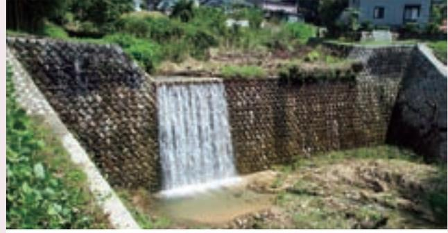
昭和14年度完成 堤高：8m 堤長：42m 形式：練石積堰堤
