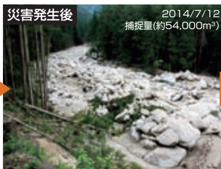
災害後の土砂等の捕捉状況
