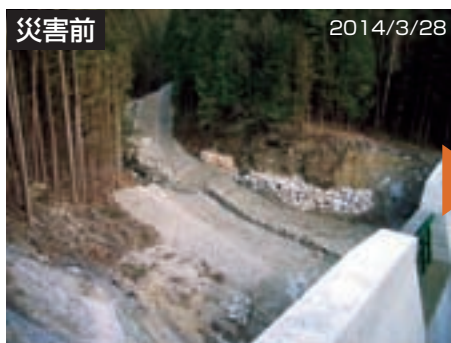
梨子沢第2砂防堰堤(空っぽの状態)
