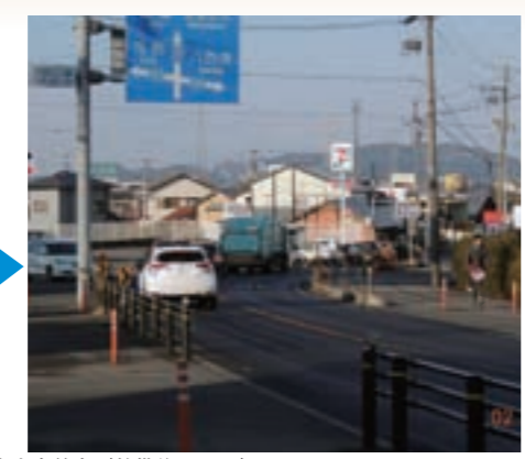
上恵土交差点 (整備後 H29.2)
