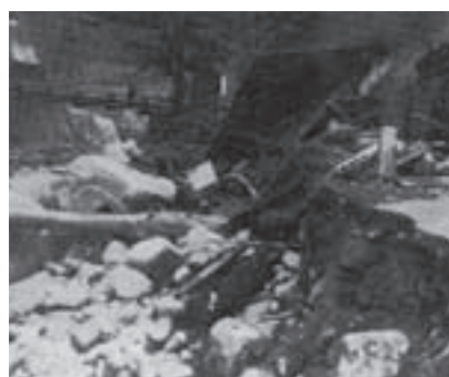
川上地区の被災状況（出典「50年の歩み」）
