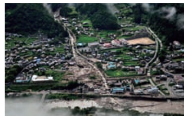
災害発生直後の様子
