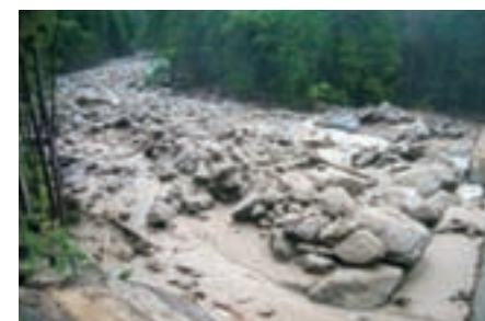
土砂堆積状況（梨子沢第2砂防堰堤）
