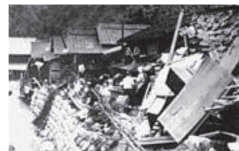
土石流に破壊された家屋
