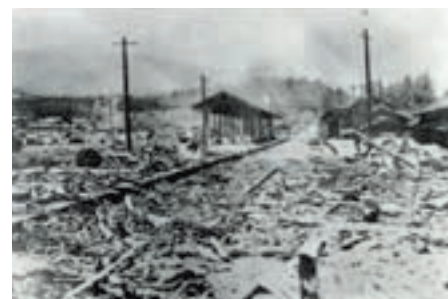
大きな被害を受けた中津川駅
