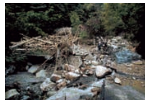
中津川支線 一の沢の土砂流出状況
