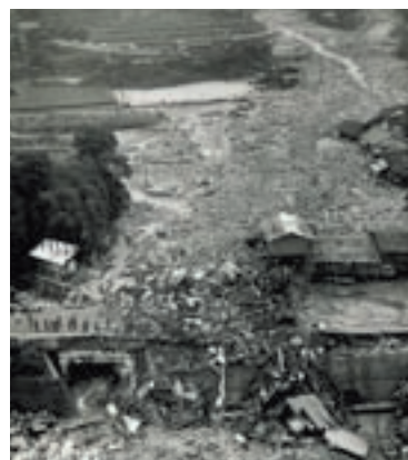
大沢田川の土砂流出状況
